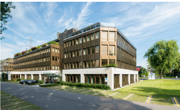
Südsicht des Geschäftshauses Neuhof – mit markanter, bronzener Metallfassade
