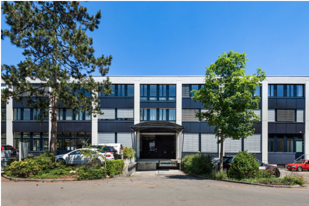
Ansicht Rampe - Warenlift
