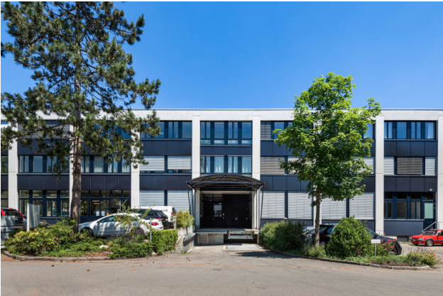
Ansicht Rampe - Warenlift
