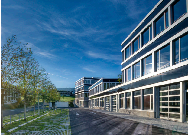
Hochwertige Glas-, Metallfassade mit Sektional-Einfahrtstoren im EG
