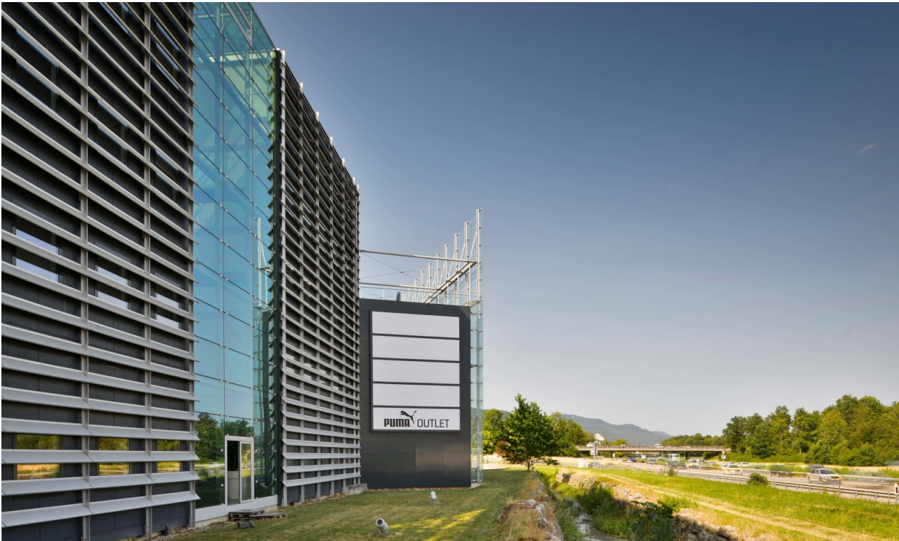
Aussenansicht Richtung Zürich
