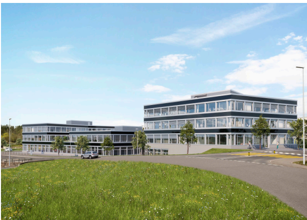
Vom Dorfzentrum Buchrain kommend mit Einfahrt Stegmattstrasse
