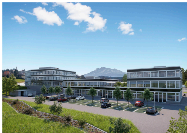
Rückseite der Gebäude 1, 3, 5 (von links)
