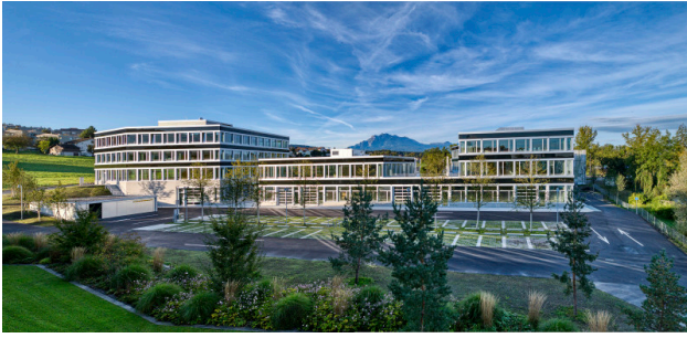
Rückseite der Gebäude 1, 3, 5 mit Pilatusblick
