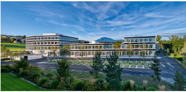
Rückseite der Gebäude 1, 3, 5 mit Pilatusblick
