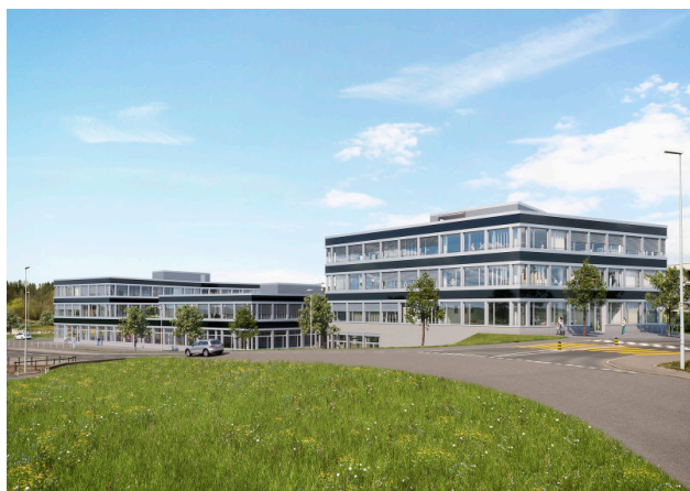
Vom Dorfzentrum Buchrain kommend mit Einfahrt Stegmattstrasse
