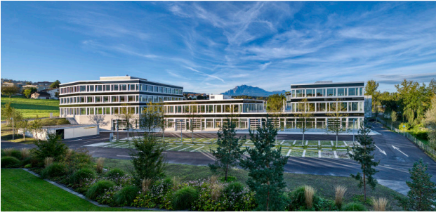
Rückseite der Gebäude 1, 3, 5 mit Pilatusblick
