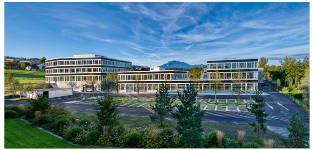
Rückseite der Gebäude 1, 3, 5 mit Pilatusblick
