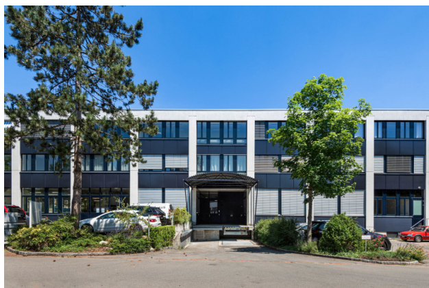
Ansicht Rampe - Warenlift
