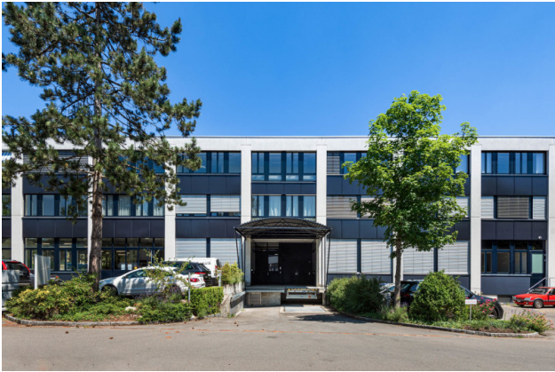
Ansicht Rampe - Warenlift
