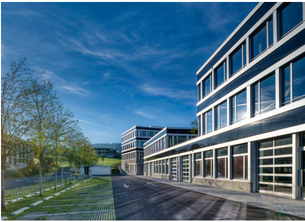
Hochwertige Glas-, Metallfassade mit Sektional-Einfahrtstoren im EG
