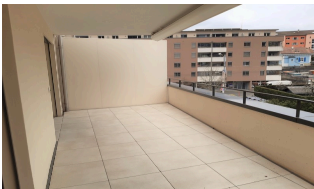
Terrasse d'un autre appartement du bâtiment pour illustration
