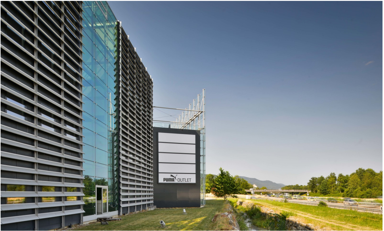
Aussenansicht Richtung Zürich
