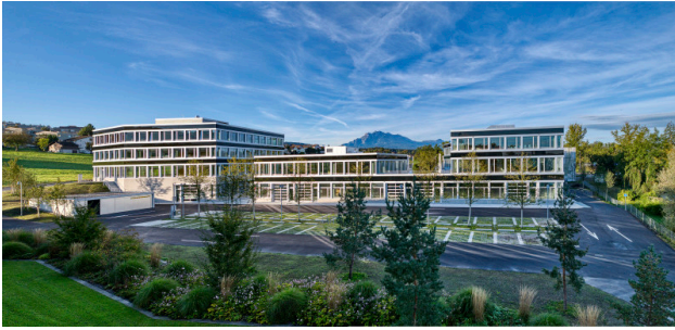
Rückseite der Gebäude 1, 3, 5 mit Pilatusblick
