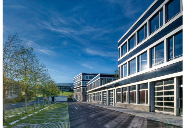
Hochwertige Glas-, Metallfassade mit Sektional-Einfahrtstoren im EG
