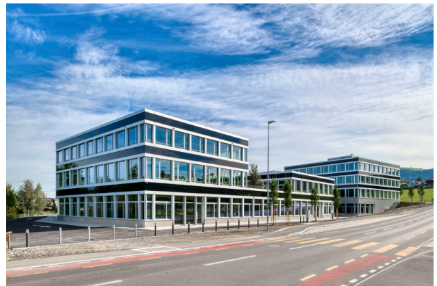
Kreuzung Dorf-, Hauptstrasse in Richtung Dorfzentrum Buchrain
