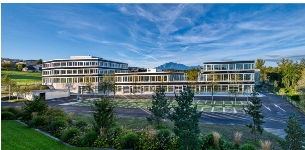
Rückseite der Gebäude 1, 3, 5 mit Pilatusblick
