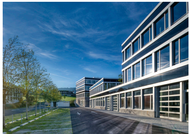
Hochwertige Glas-, Metallfassade mit Sektional-Einfahrtstoren im EG
