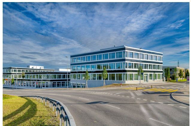
Vom Dorfzentrum Buchrain kommend mit Einfahrt Stegmattstrasse (Gebäude 1 im Vordergrund)
