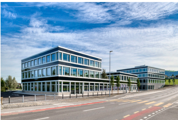
Kreuzung Dorf-, Hauptstrasse in Richtung Dorfzentrum Buchrain
