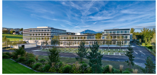
Rückseite der Gebäude 1, 3, 5 mit Pilatusblick
