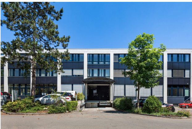
Ansicht Rampe - Warenlift
