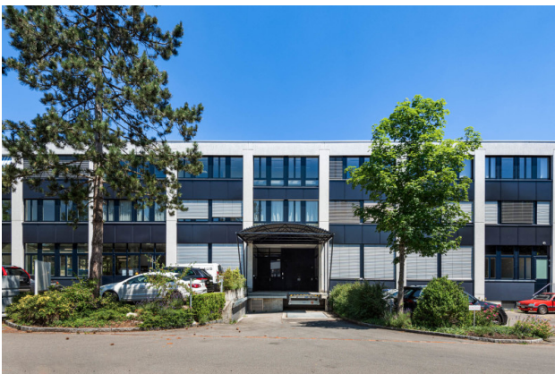
Ansicht Rampe - Warenlift
