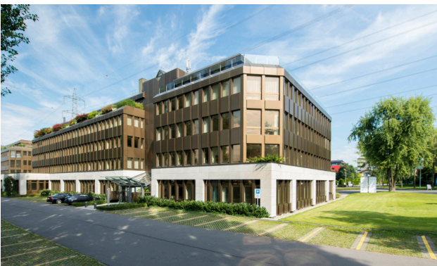
Südansicht des Geschäftshauses Neuhof - mit markanter, bronzener Metallfassade
