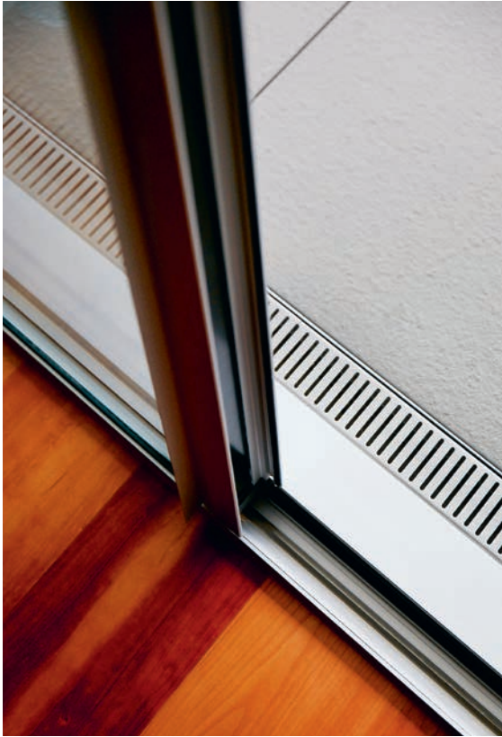
< Sorgfältige Detailarbeit: Übergang vom Innenraum auf die Terrasse.
