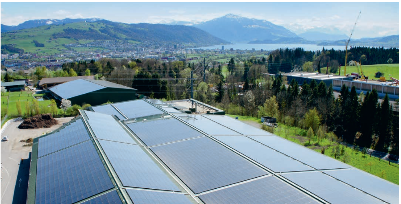
^ Immer häufiger wird die Gebäudehülle – das Dach oder auch die Aussenwände – zur Produktion von Wärme und Strom genutzt. Im Bild die rund 10000 Quadratmeter grosse Photovoltaikanlage auf den Dächern der zur Alfred Müller AG gehörenden Kompostier- und Ökostromanlage Allmig in Baar. Foto Alfons Gut
