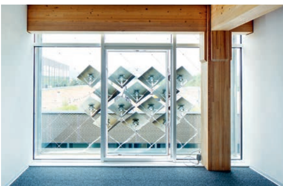
^ < Adaptive Solarpanels an der Fassade des House of Natural Resources. Hinter dem Fenster befindet sich ein Büro.
