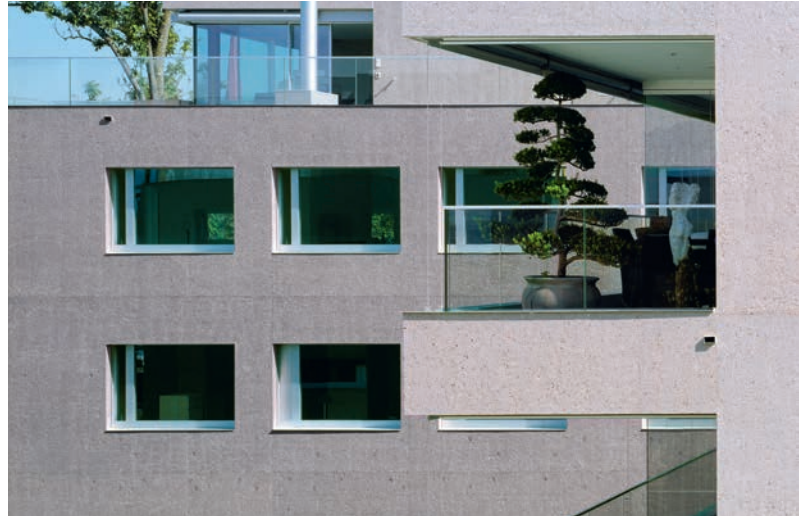
v Eine Betonfassade ist sehr langlebig, unterhaltsarm und bietet einen guten sommerlichen Wärmeschutz.
